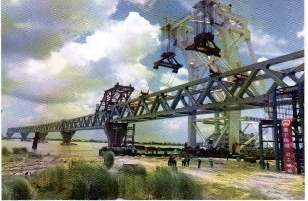
ষপ্তের পদ্মা সেতুর চলমান স্প্যান স্থাপন কার্যক্রম
